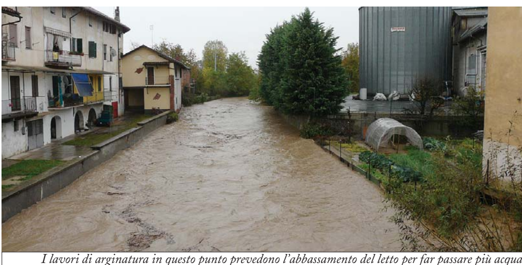
I lavori di arginatura in questo punto prevedono l'abbassamento del letto per far passare più acqua
